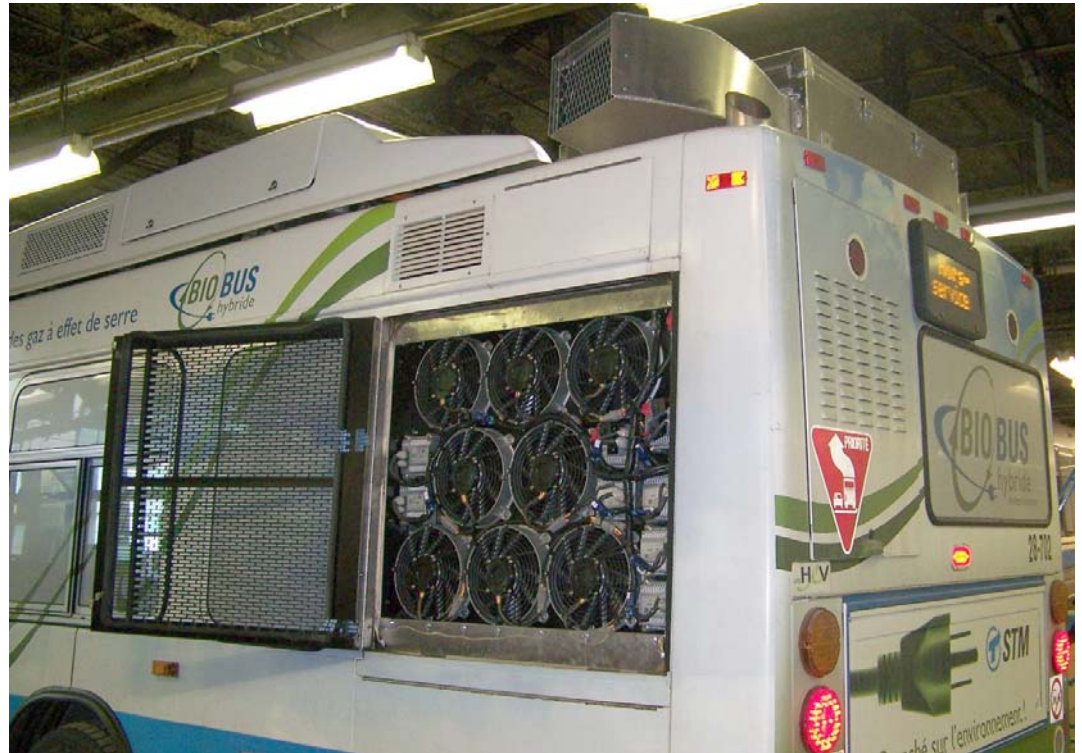
Figure H-3 Les composantes du système de ventilation électrique du radiateur suite à la modification
